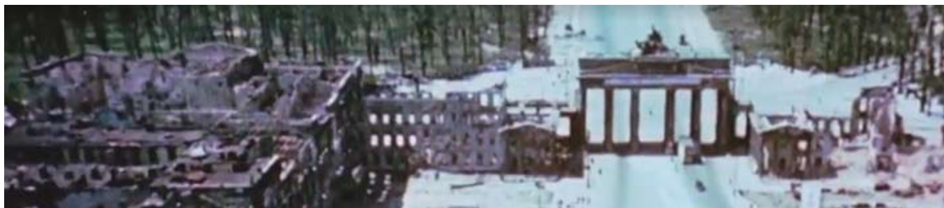
Quelle: Bildauschnitt aus einer Wochenschau-Dokumentation
